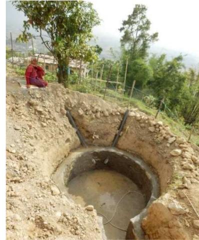
Aufbau einer Biogasanlage |
